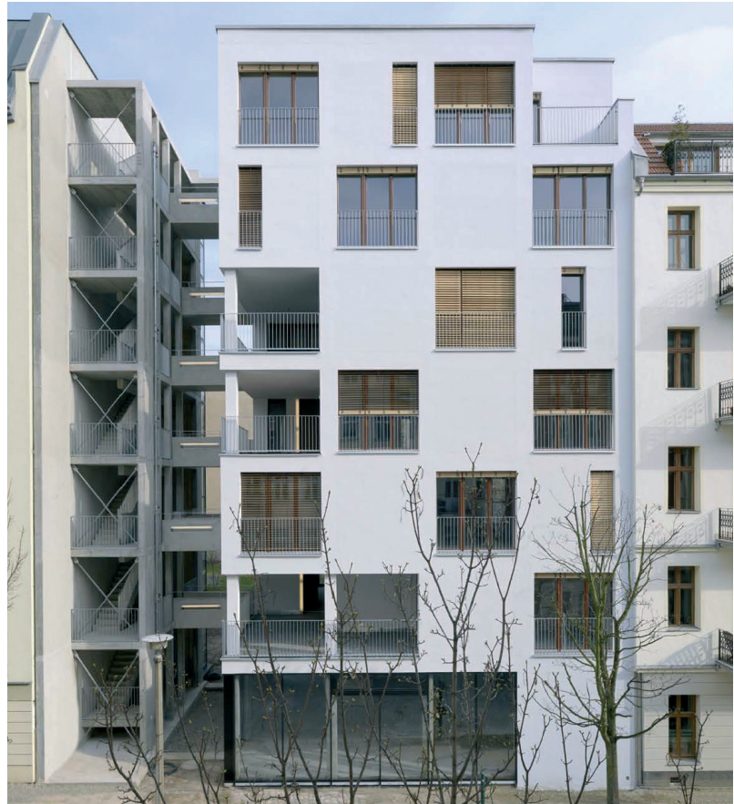
Abb. 11.8: Straßenfassade, Bild: Büro Klingbeil + Kaden
