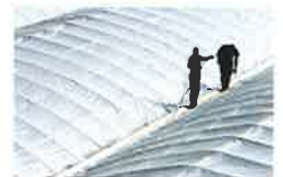
Dach Aue-Pavillon; Foto: Heiko Meyer; © documenta G.m.b.H./Meyer
